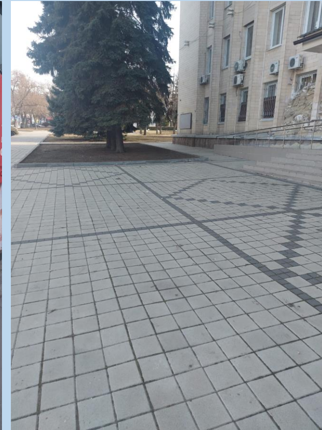
Фото №7 пандус у будівлі Міської ради та Виконавчого комітету на площі Миру
